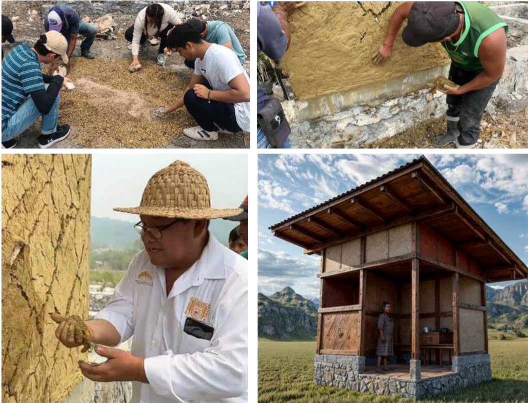
Taller de construcción de muros de bajareque.
