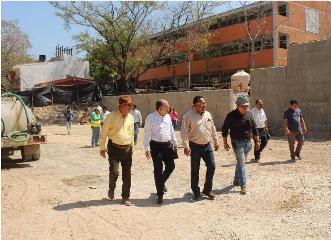
Recorrido para verificar los avances del nuevo edificio
