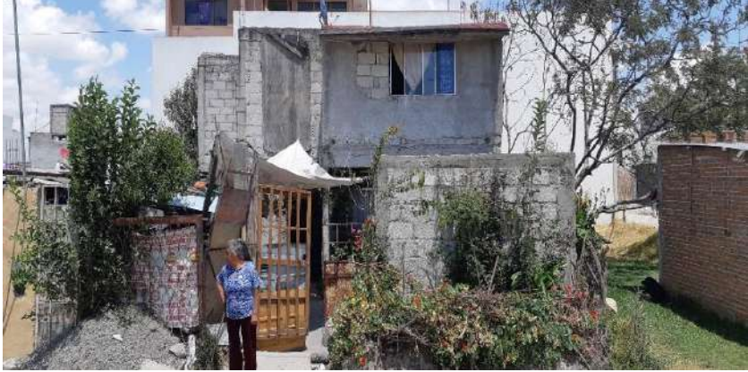
Figura 2. Vivienda precaria de autoconstrucción en El Castillo.
