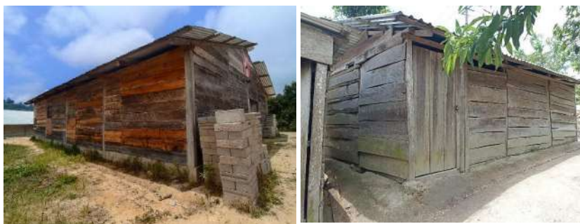
Figura 12. Viviendas con muros de madera y cubierta de lámina.
