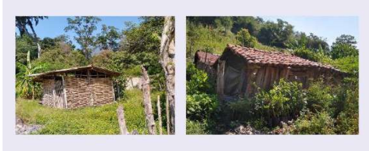
Figura 5. Viviendas construidas con técnicas y materiales tradicionales
