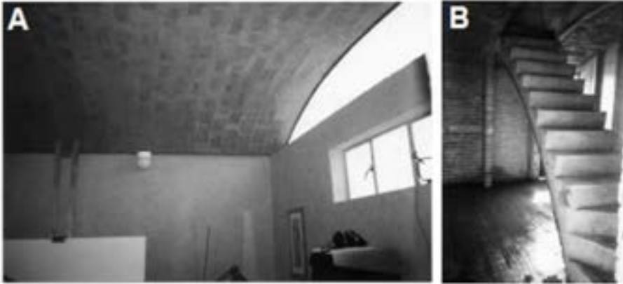
Figura 2.11-. Bóvedas de ladrillo, Arq. Mario Larrondo. Foto A y B, Vivienda en la Ciudad de México D. F.
