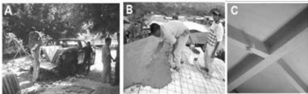
Figura 1.32. El sistema de techo Placa Losa. En la foto A, producción de piezas de este sistema en la facultad de arquitectura de la UNACH. En la foto B, construcción del techo para interior de la vivienda.
