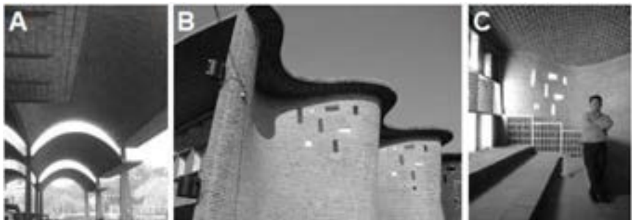
Fig. 2.6- La obra de Eladio Dieste se caracteriza por basarse en la geometría, la búsqueda de la optimización de los materiales. En la imagen A, Nave industrial cubierta de bóvedas de cerámica armada. La foto B y C, la iglesia de Atlántida, donde la geometría es la base del funcionamiento estructural del edificio hecho con cerámica armada.
