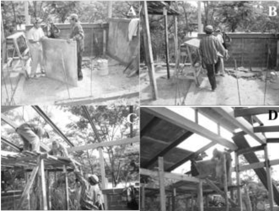
Figura 3.21. Colocación de componentes techo Domotej sin la necesidad de equipos especiales
