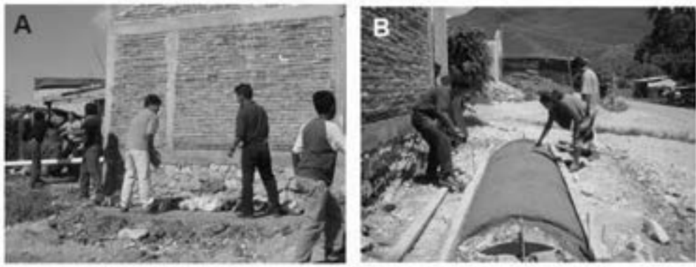
Figura 1.31. Fabricación de molde para la fabricación de piezas del techo de una vivienda con el Programa 10x10 Chiapas. En las fotos A y B, se muestra la fabricación de moldes para piezas.
