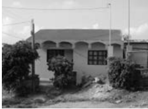
Figura 1.38. Construcciones del programa 10x10 Chiapas. En la foto, vivienda cubierta con bóveda Ferrocemento, propuesta por la Universidad Autónoma de Yucatán, México.
