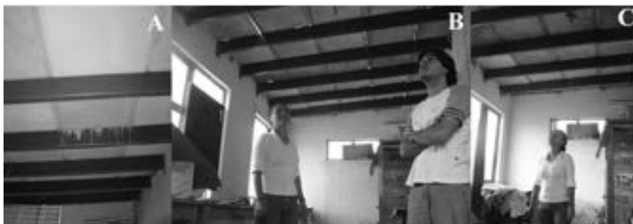
Figura 3.5. Espacio recubierto con el sistema Domozed, antes de colocar la capa de compresión, en la foto B, y después de colocar la capa de compresión, foto A y C.
