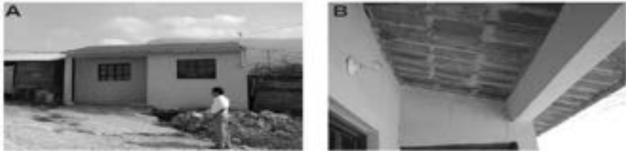
Figura 1.1. La foto A, vivienda construida por la Oficina de la Vivienda, con techo Armada Cerámica, transferidos por Ariel Ruchansky en el programa 10x10 Chiapas. B, de cerámica Detalle del techo en el programa Armados de la Cámara de 10x10 Chiapas.
