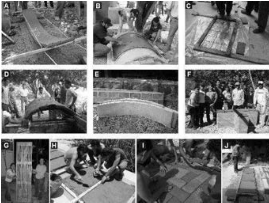
Fig. 3.43. Tecnologías que se imparten en los talleres de transferencia de tecnología. Fotos: A, Dovela de ferrocemento, B- Bóveda de ferrocemento, C-placa losa y techo térmico, D, Bóveda con cimbra deslizable. E-Cerámica armada. F, Muro Tapial. G-Muro Quincha prefabricada. H, Muro térmico. I-Domotej. J, Domozed.
