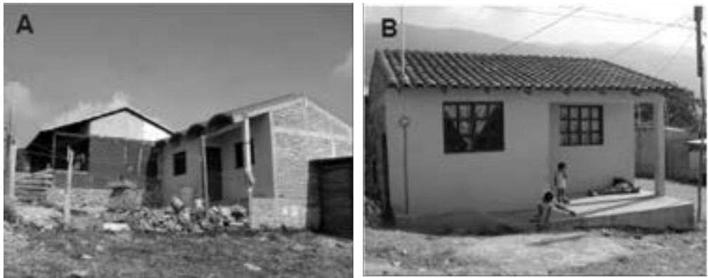
Figura 1.37. Construcciones del programa 10x10 Chiapas. En la foto A, vivienda cubierta con bóveda de Cimbra deslizable, propuesta por INVI. En la foto B, cubierta con baldosas de arcilla, tipo español, colocado sobre soporte de luz, de la Universidad Politécnica de Cataluña, España.
