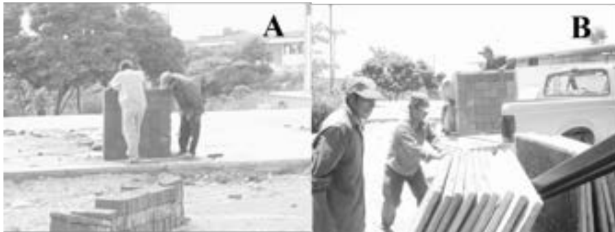
Figura 3.17. Fotos A y B, muestran cómo cargar las piezas Domotej, preferentemente la pieza debe estar en posición vertical.
