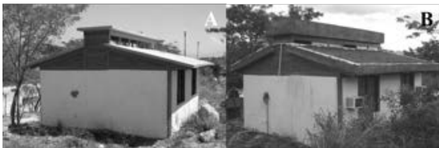
Figura 3.40. Sistemas de techo Domotej antes (foto A) y después (fotoB) de complementar el techo verde, construido en un terreno de la Facultad de Arquitectura, UNACH.
