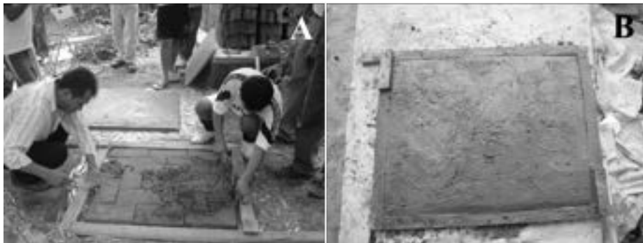
Figura 3.13. Foto A, colocación de mortero cemento-arena 1:3 sobre el petatillo, foto B, Cubierta de 1.00 cm mortero con un espesor de 1 cm.
