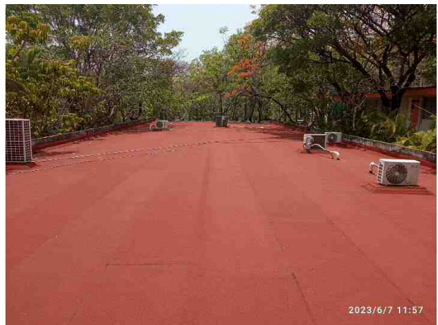
Imagen. Losa. edificio D
