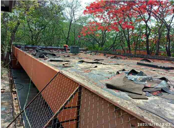
Imagen. Levantando impermeabilizante, edificio B
