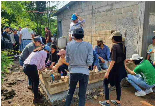
Imagen. Construcción de Cocina con materiales alternativos como BTC
