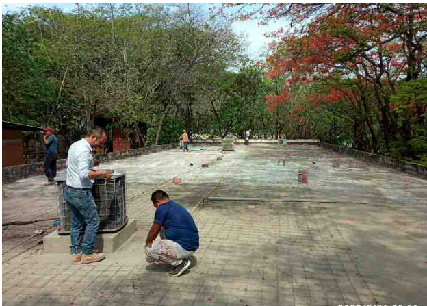
Imagen. Colado de losa, edificio B
