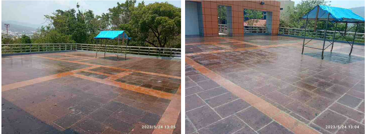
Imagen. Laqueado final tipo epóxido, edificio Polifuncional
