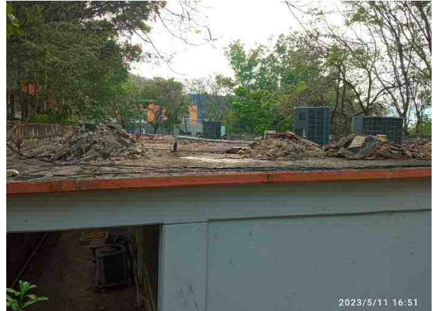
Imagen. Levantando impermeabilizante, edificio D
