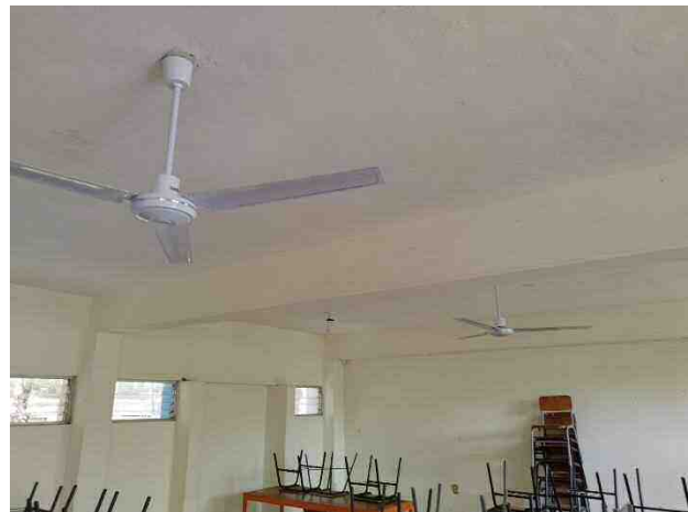
Imagen. Sustitución de ventiladores
