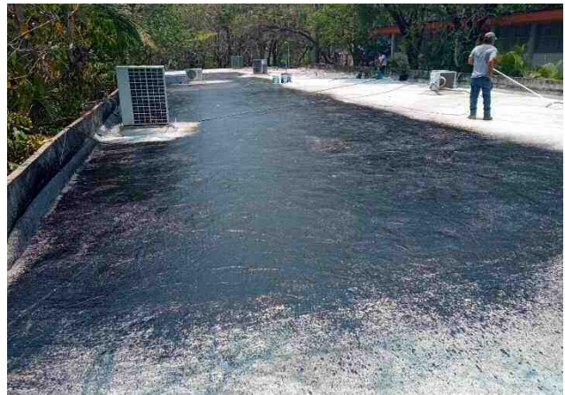
Imagen. Colocación de chapotote, edificio D
