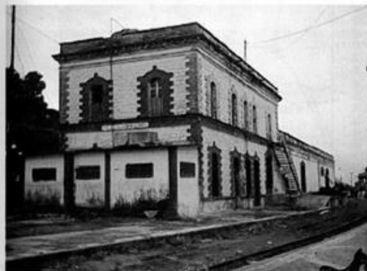
Foto 1: Estación de ferrocarril de Huixtla.
