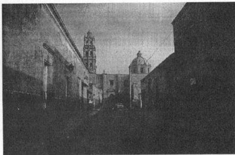
Perspectiva de calle interrumpida por el remate visual del templo de San José en la ciudad de Morelia
