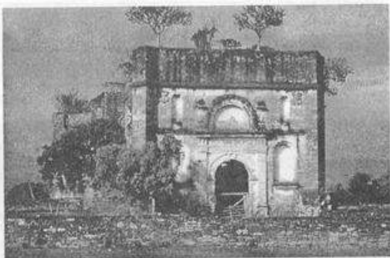
Fachada principal del templo de Copanaguastla. Actualmente ha sido retirada la vegetación que se observa en él.
