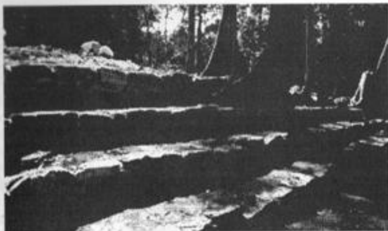
4. Último tramo de la gran escalinata del Grupo Frey, en el cual se aprecia el remetimiento de la nueva argamasa con respecto al paño general de los escalones, con la finalidad de distinguir los agregados modernos de los materiales originales.
