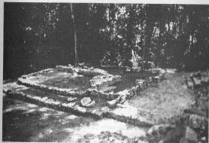
3. Vista del edificio 2 del Grupo Frey una vez restaurado. Este tipo de construcción fue hecho con piedra caliza burdamente labrada.
