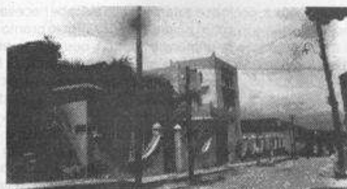
Casa de la familia Muñoz, ubicada en Primera Sur y Primera Oriente, demolida en 1982.
