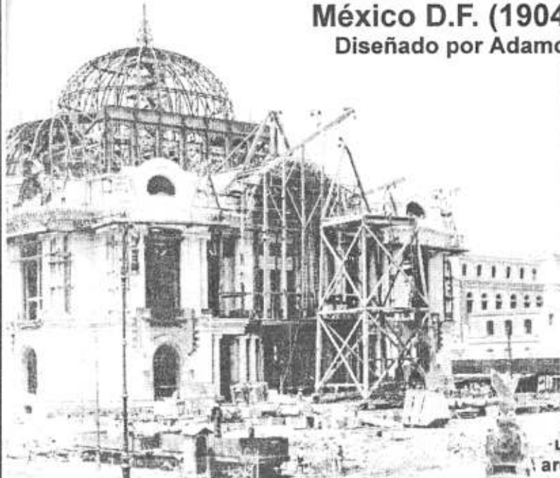
Estado de la construcción en 1910
