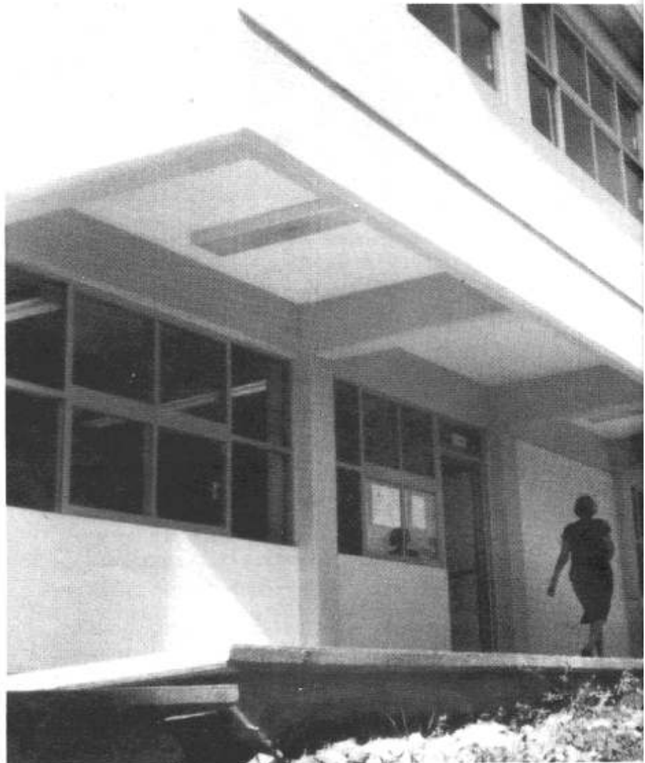
Vista parcial del nuevo edificio de aulas y cubículos para profesores
