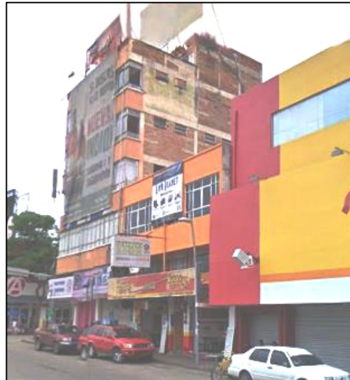
Imagen 4. Fachada lateral del Edificio Corzo. Modificado con base en Google, 2012. (Zenteno, 2018).
