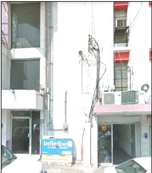
Imagen 5. Cableado en exceso y aparatos de aire acondicionado en fachada, Modificado con base en Google 2015.
