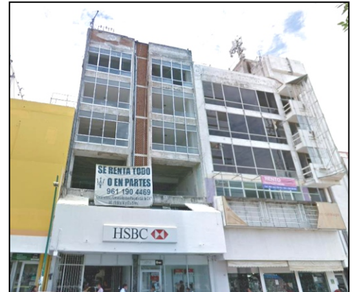
Imagen 8. Edificaciones en parcial abandono. Modificado con base en Google, 2017. (Zenteno, 2018)
