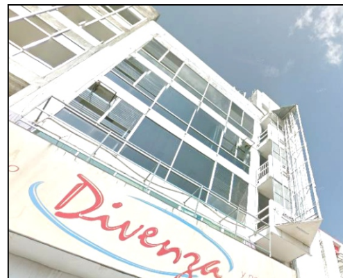
Imagen 6. Estructuras publicitarias inutilizables en fachadas. Modificado con base en Google, 2015. (Zenteno, 2018).
