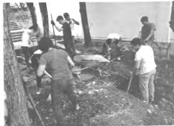
Imagen 4. Trazo del proyecto y excavación de la para cimentación de estructura de cemento armado.
