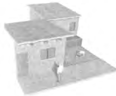
Apariencia de un techo construido en la segunda etapa, con el sistema prefabricado.
