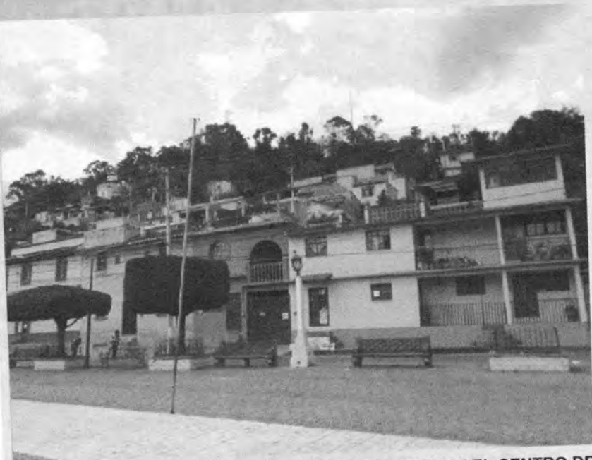
IMAGEN 2. PARAMENTO NORTE DEL CENTRO DE BARRIO DE SAN ANTONIO, SAN CRISTÓBAL DE LAS CASAS, CHIAPAS. Fuente: Gómez, 2012.
