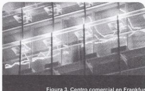
Figura 3. Centro comercial en Frankfurt
