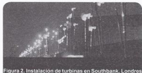
Figura 2. Instalación de turbinas en Southbank, Londres
