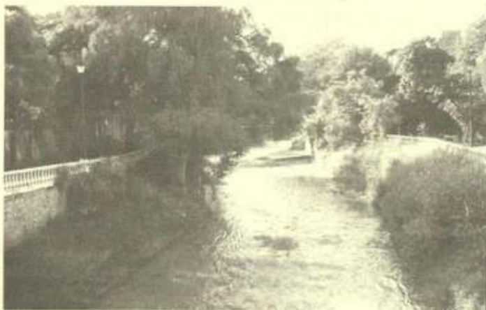
Imagen del Río Sabinal en el año 2008, se observa el deterioro ambiental en sus márgenes (Foto de archivo Marco A. Pérez A.).
