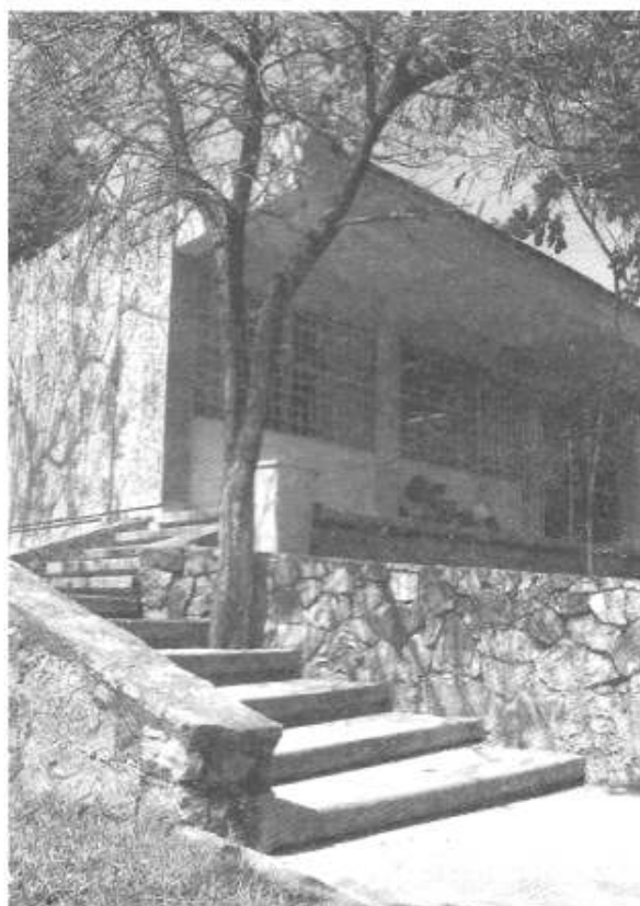
Biblioteca de la Facultad de Arquitectura - UNACH
