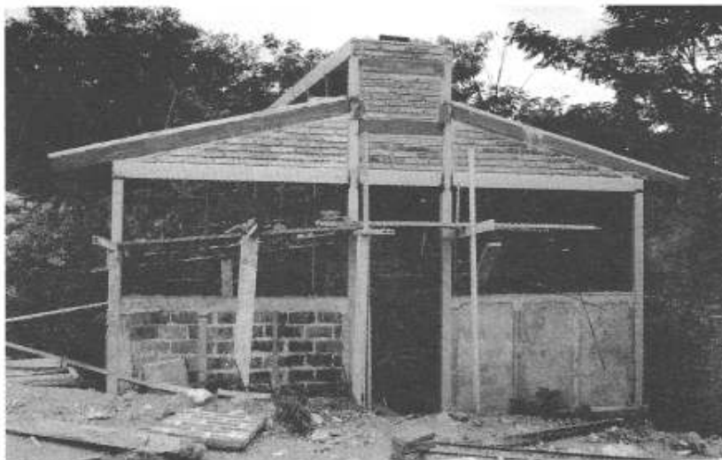
Imagen 5: Construcción de paredes con las placas prefabricadas, utilizando la estructura como guía, con refuerzo vertical en la junta, logrando un muro reforzado y con una cámara de aire que aumenta el tiempo de transmisión de calor.
