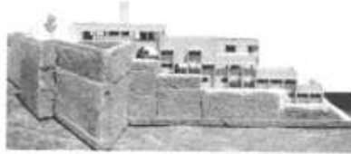
Imagem 6.-Vista Fachada Norte
