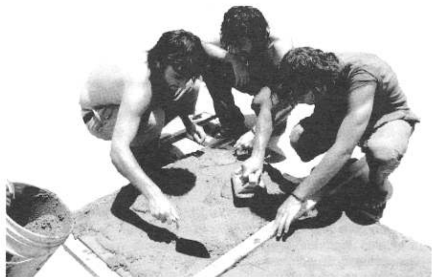
imagen 2: Fabricación de componentes de techo Domotej, capacitando a alumnos visitantes de la Facultad de Arquitectura de la Universidad Politécnica de Cataluña, coordinados por José Luis Jiménez Albores, 2004.
