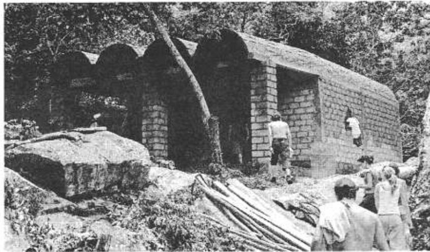
Vivienda con tecnología de cimbra deslizable en Poza Galana, Arriaga, Chiapas. Foto: Mtro. Wilder Álvarez
