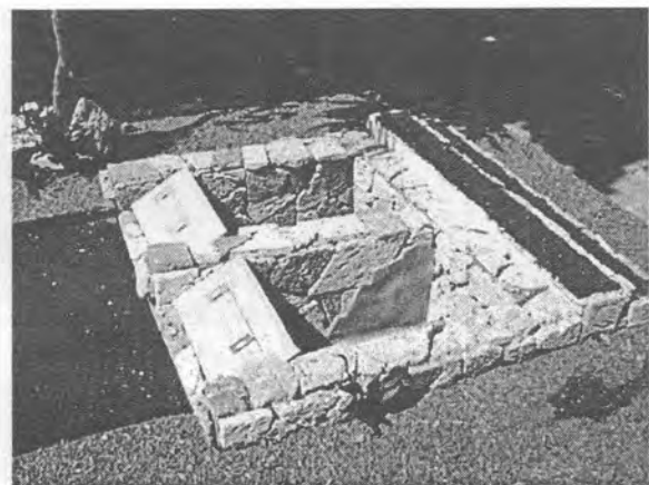
Propuesta de letrina sanitaria seca realizada por los alumnos de 8º semestre grupo B. Foto: Mtro. Franco Escamiroso.
