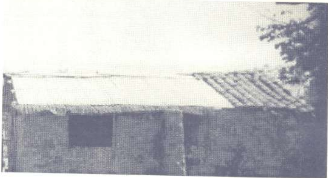
Aplicación de materiales regionales ( piedra de pepena, caliza) utilizada en muros. La cubierta es indistinta, puede ser con distintos materiales: lámina metálica, cartón o teja de barro.
