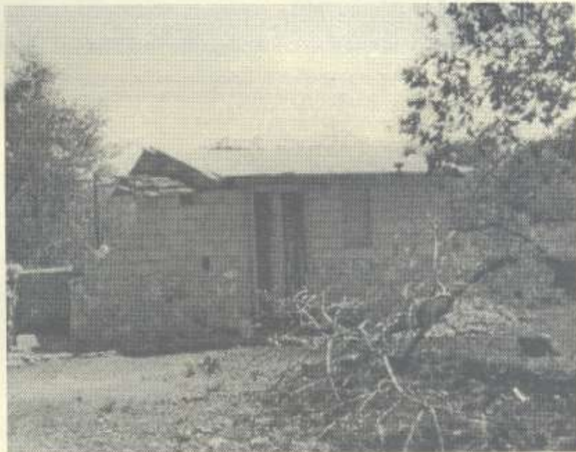
Muro de piedra de pepena (roca-caliza) sustituyendo al tabicón de cemento-arena.
